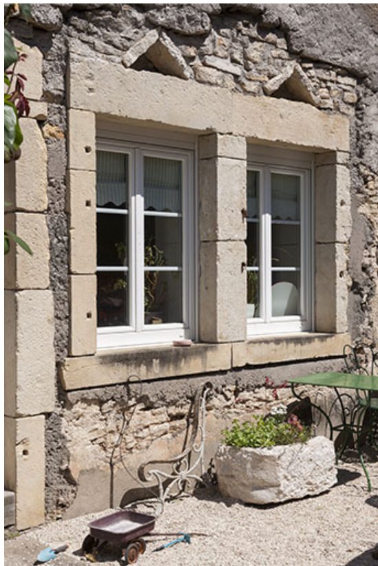
Façade remaniée, côté ferme.
