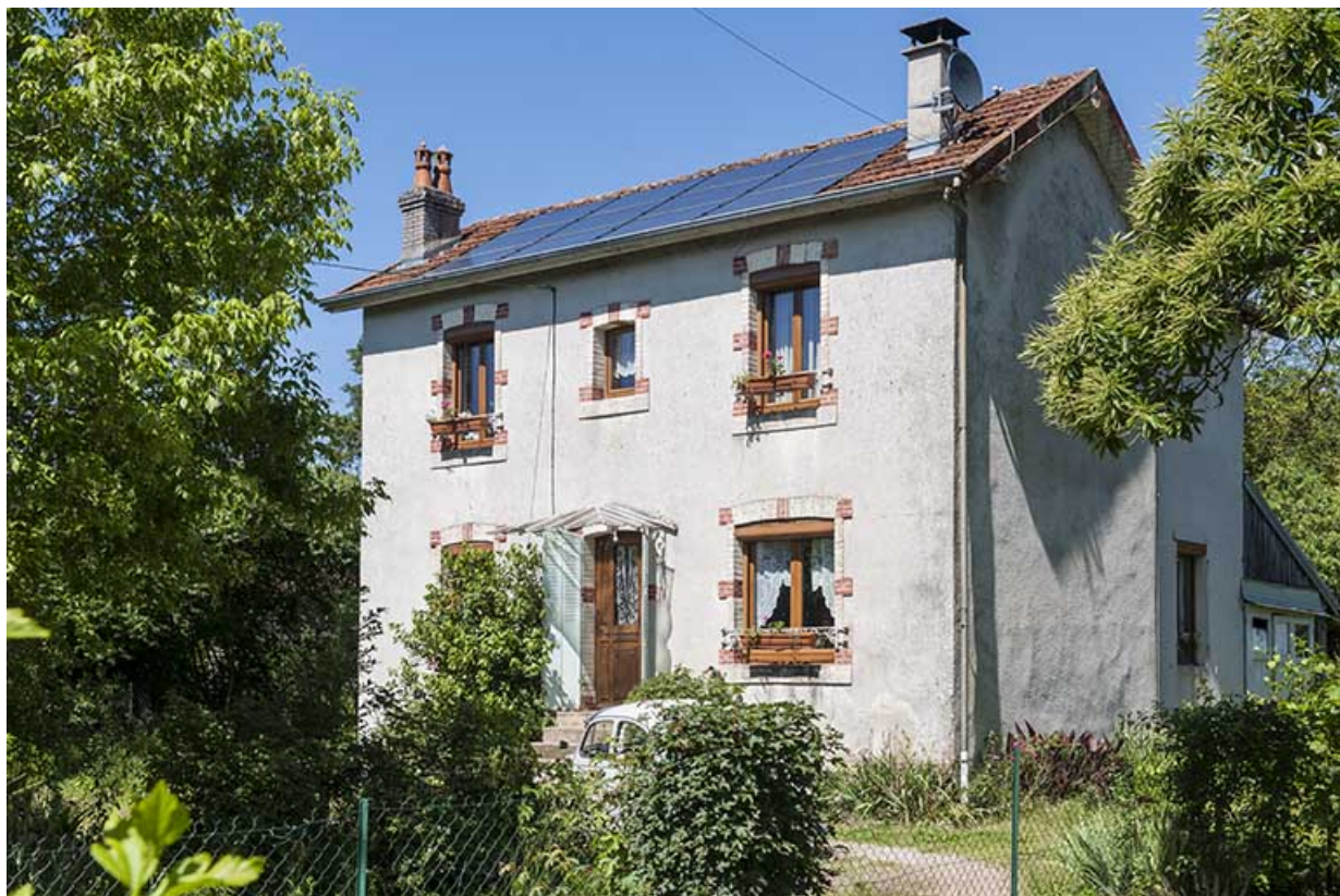
Maison située vers l'entrée du village.
