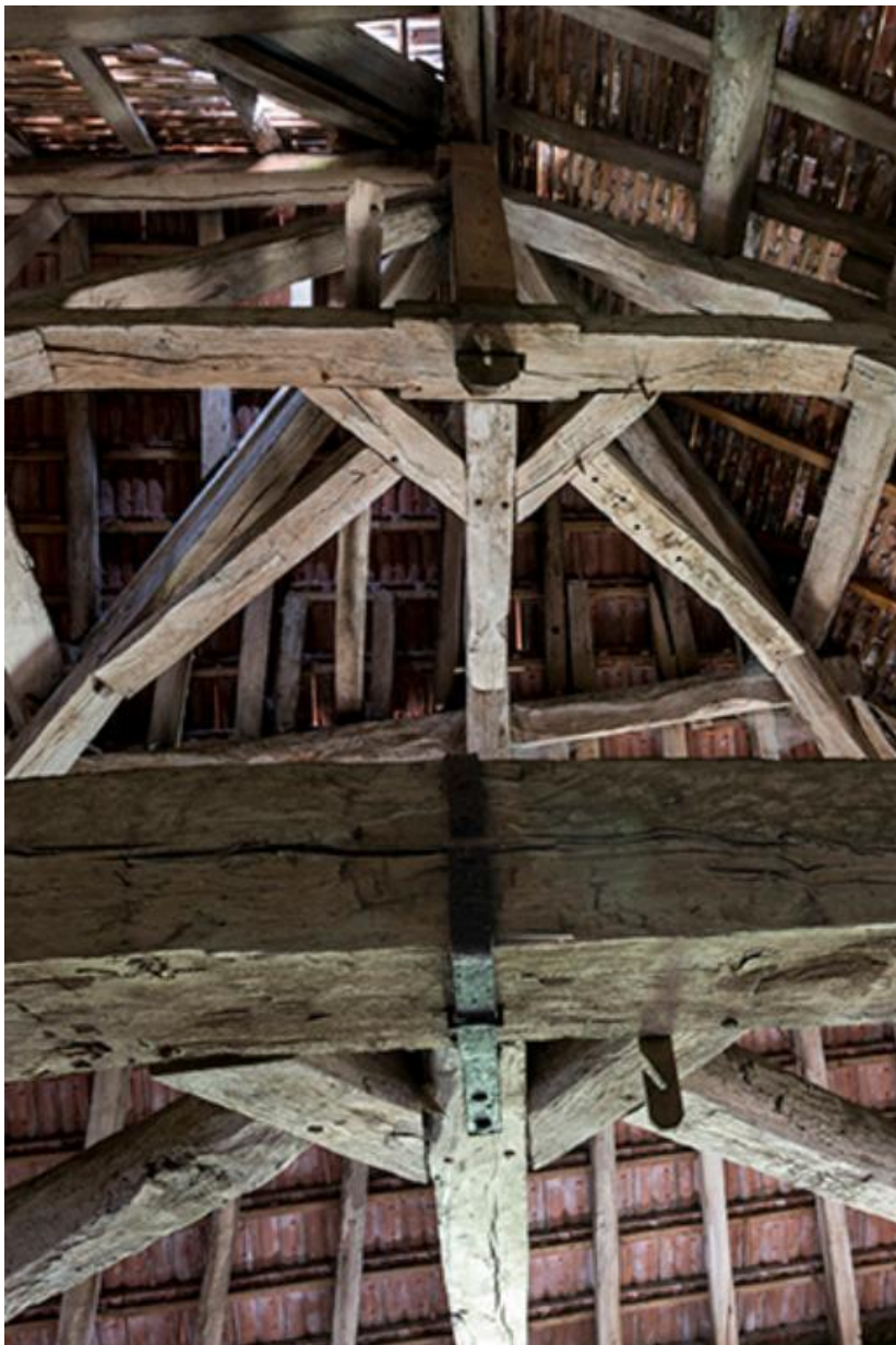
Poutrage du grenier de la chapelle
