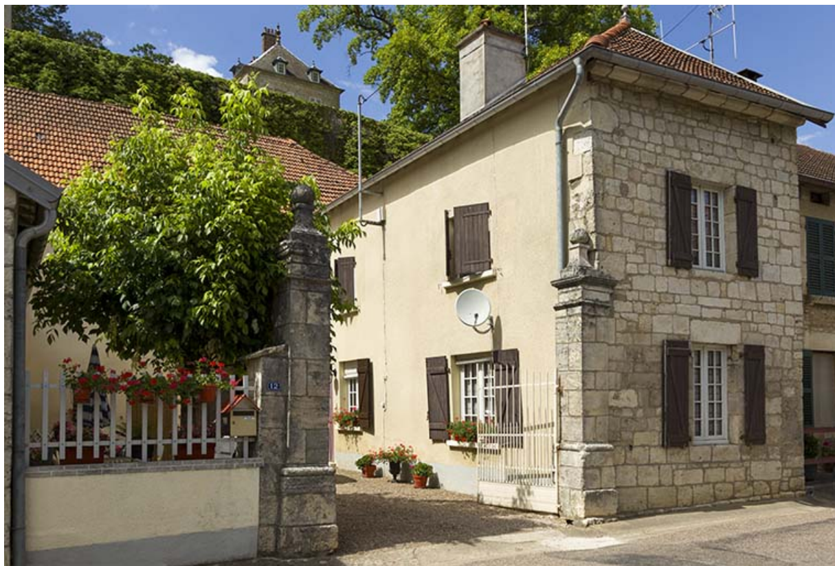
Vue de l'aile abritant le logis.
