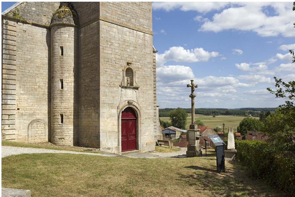
Vue du rez-de-chaussée de la tour-clocher.
