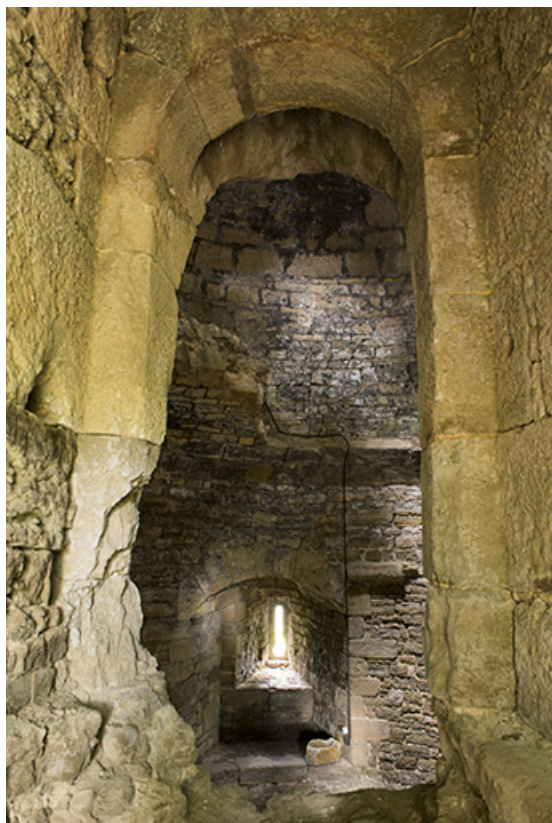
La tour ouest. Vue intérieure depuis l'entrée.
