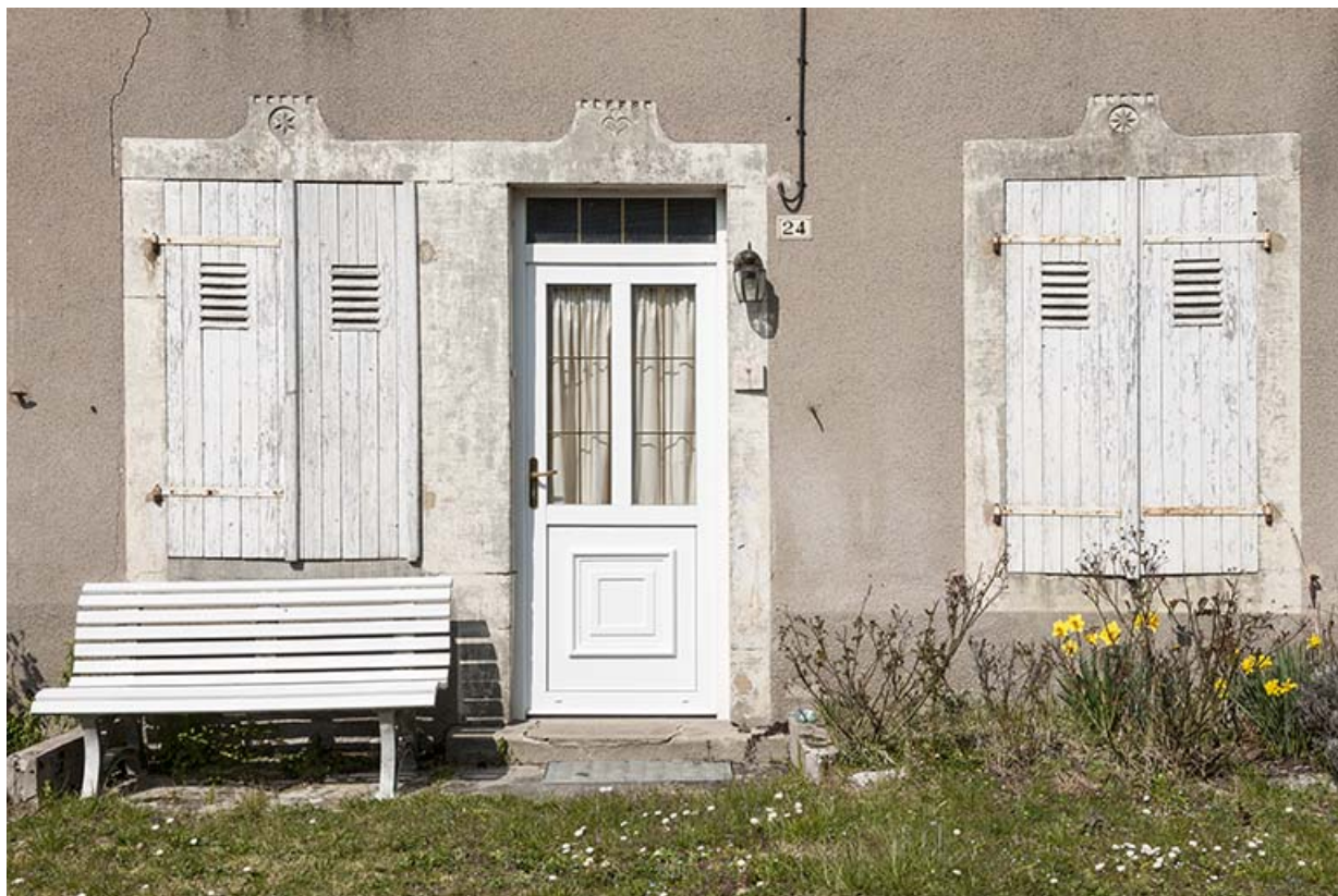
Porte d'entrée, façade principale.
