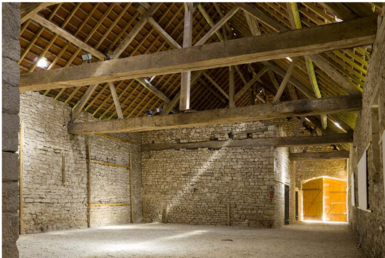
Intérieur du cuvage, en direction du sud-est.
