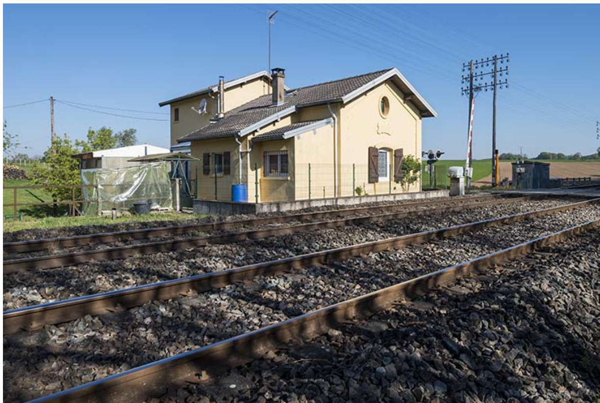
Vue depuis le Sud. 70, Chaux-lès-Port
