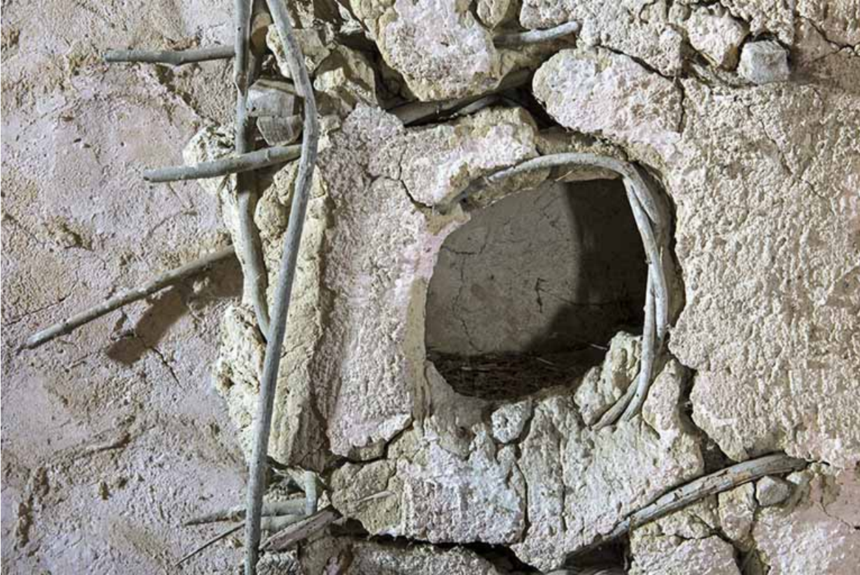
Détail d'un boulin.
