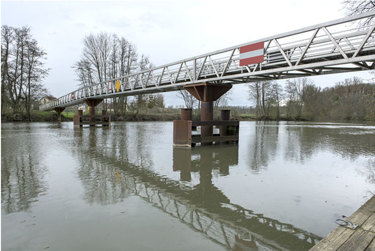
Passerelle enjambant la Saône.
