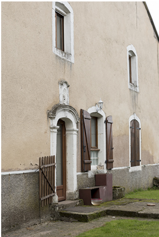
Détail de la façade antérieure.
