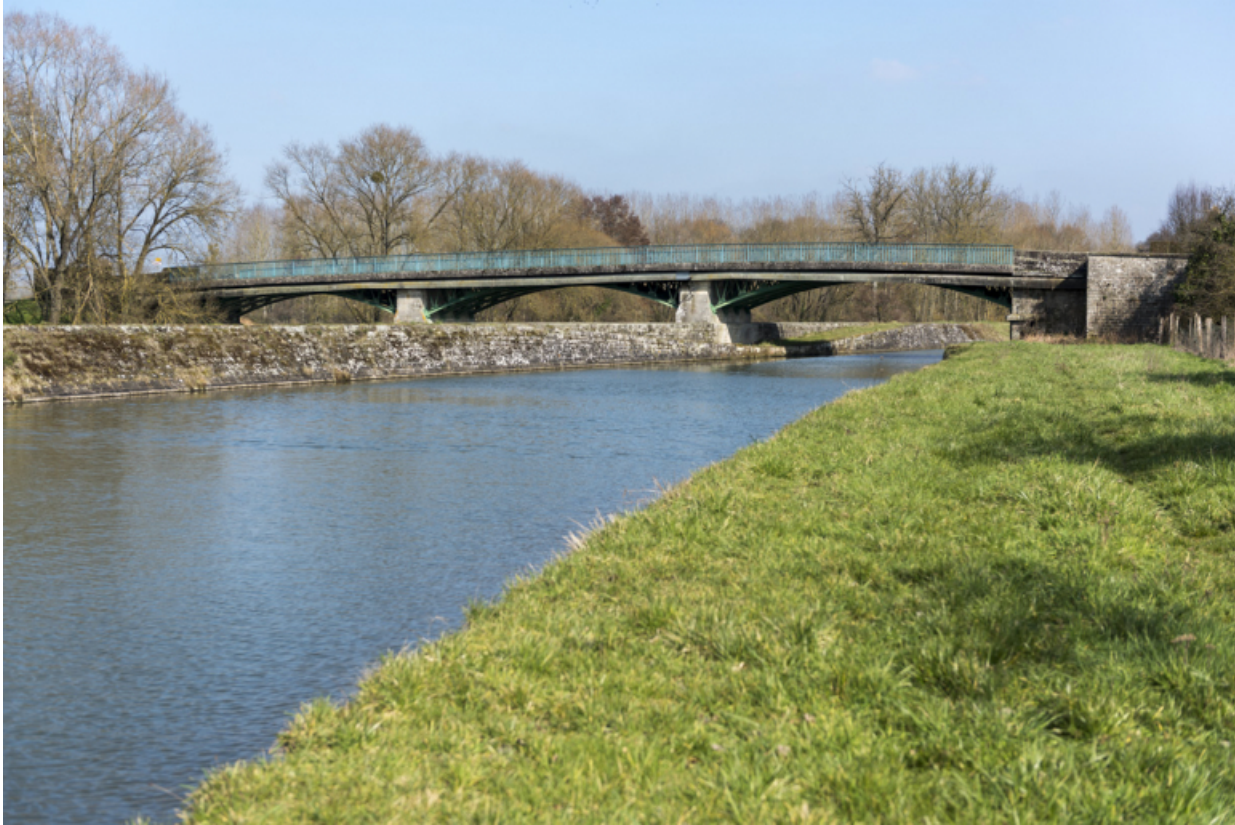
Vue depuis l'aval
