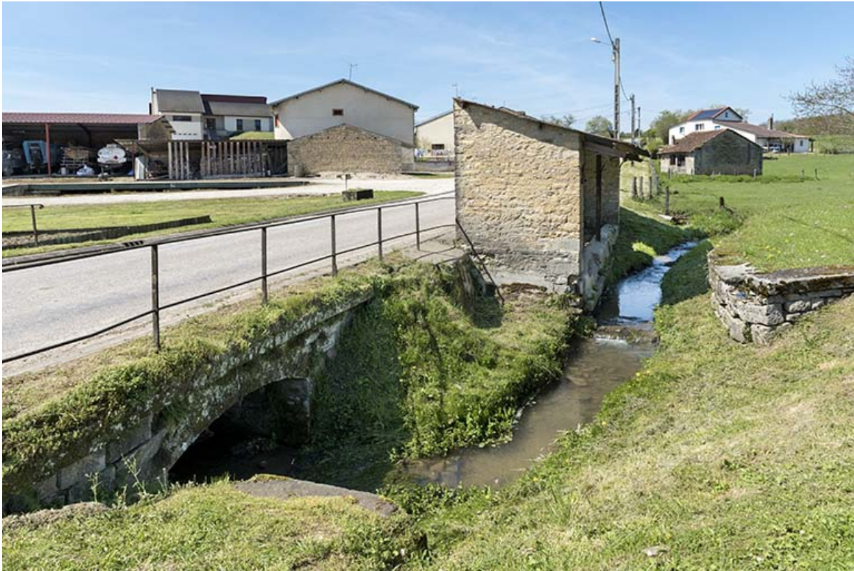
Vue générale du lavoir, Grande rue. 70, Aisey-et-Richecourt
