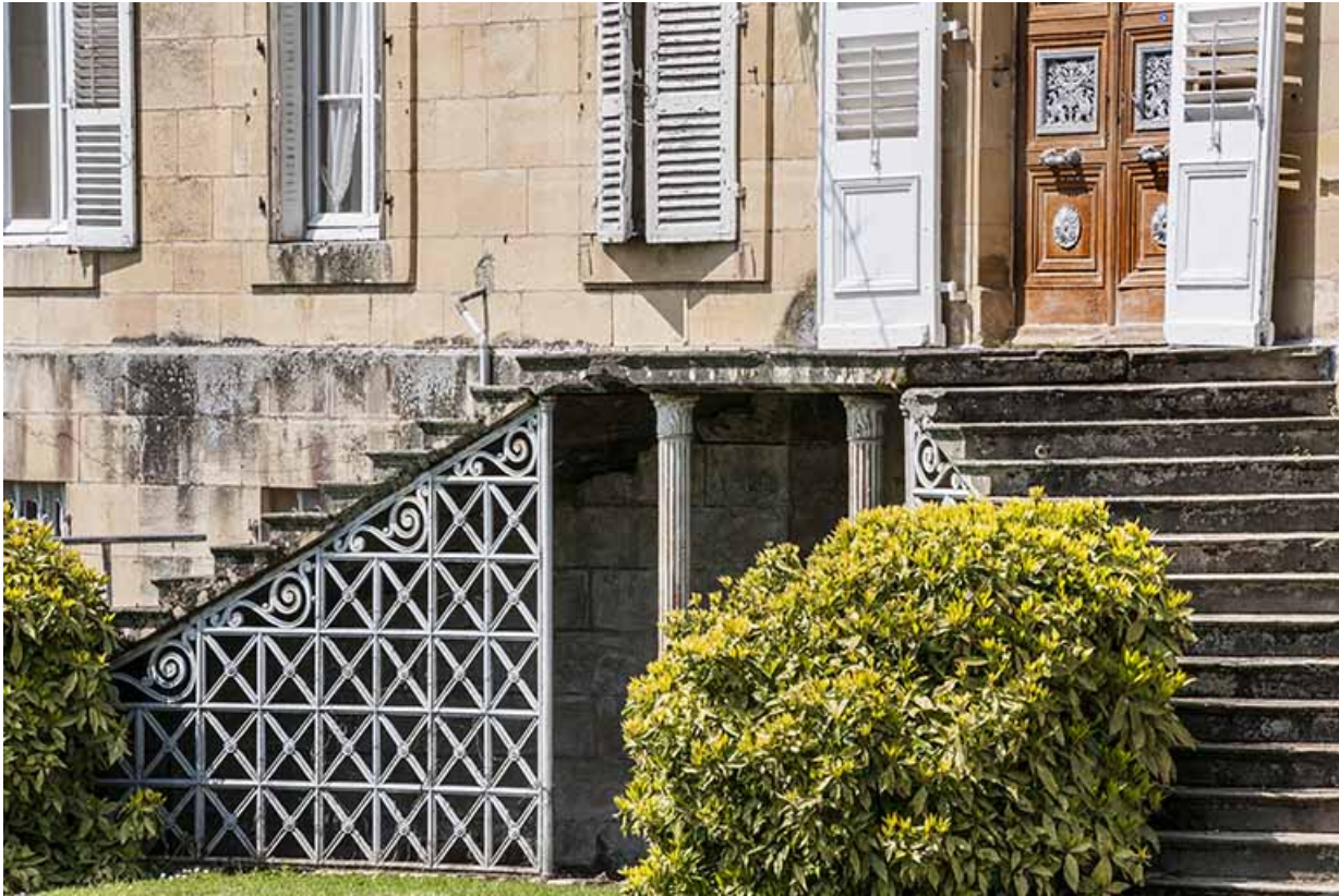
L'escalier double, façade sud.
