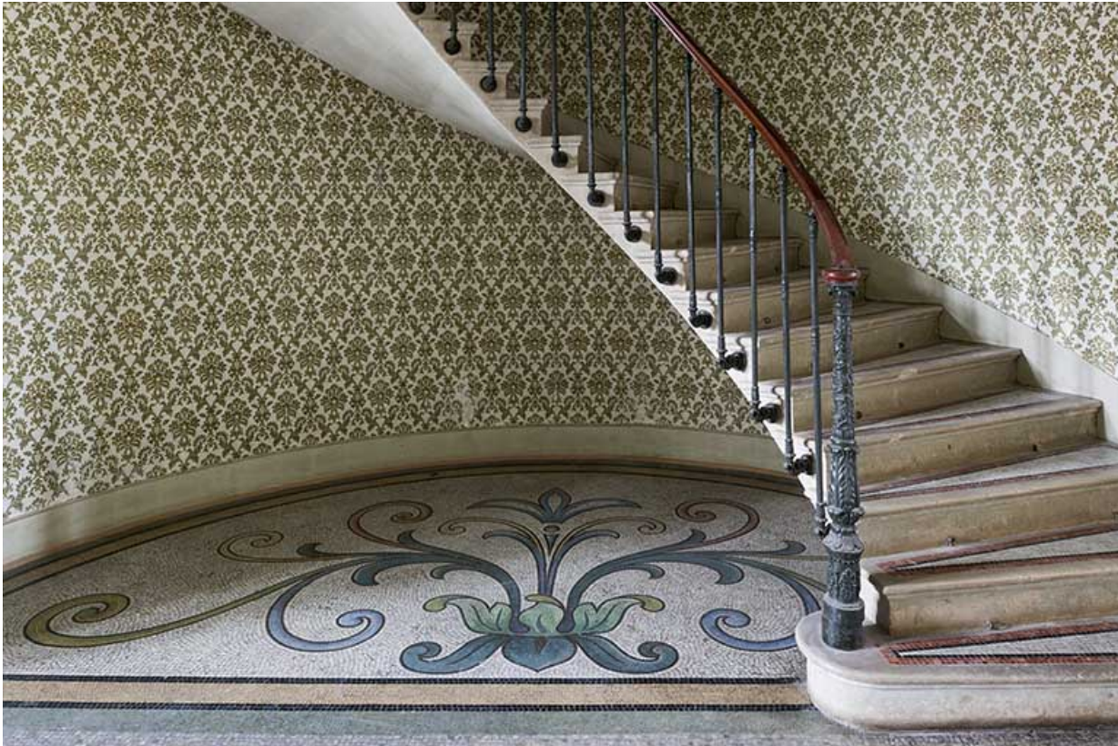
Vue générale sur l'escalier central.
