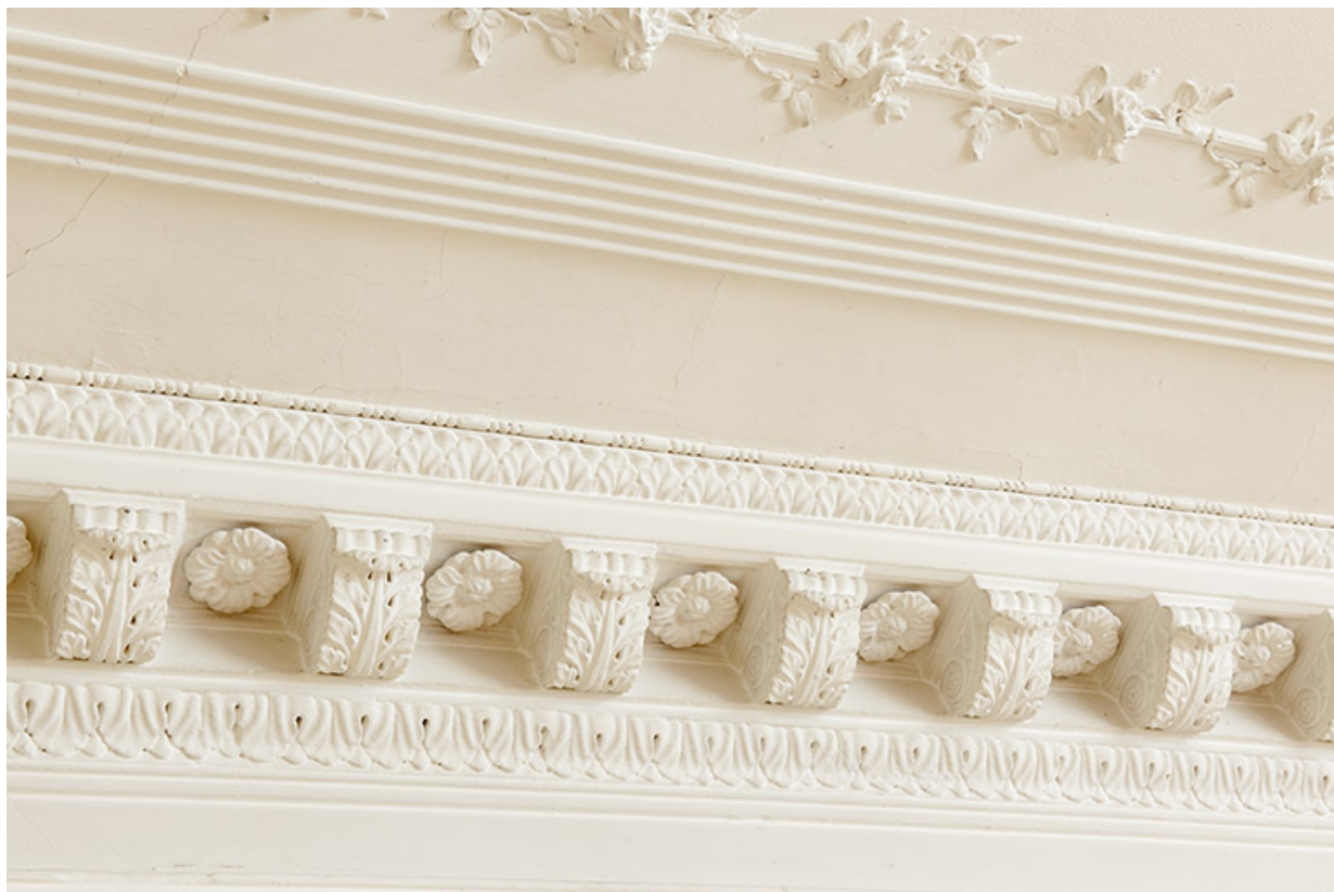
Détail de la corniche du plafond.
