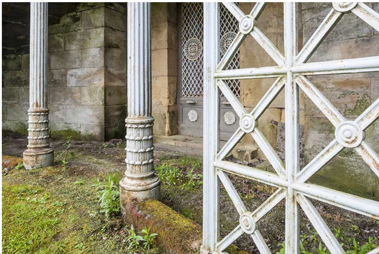
Détail sur l'armature métallique.
