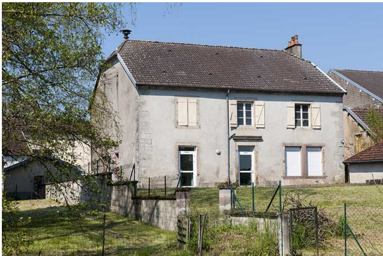
La façade postérieure.
