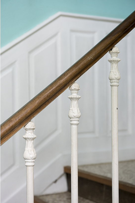
Détail de la rambarde et du garde-corps.
