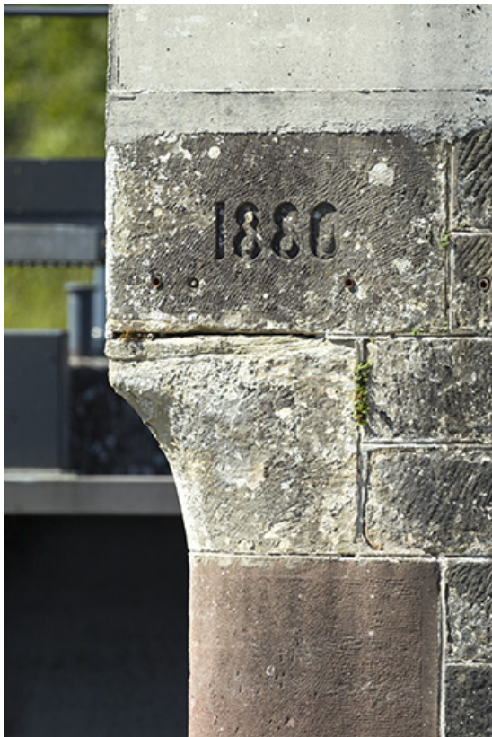
Date portée 1880 dans la maçonnerie (aval).
