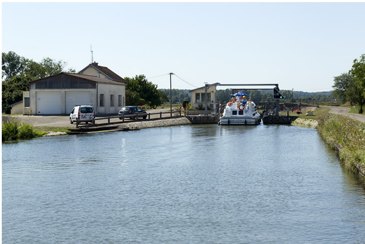
Depuis l'amont (nord), vue du site d'écluse.
