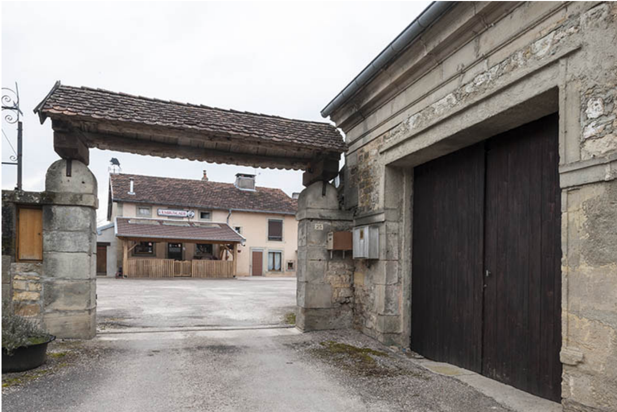
Ancienne maison des soeur.
