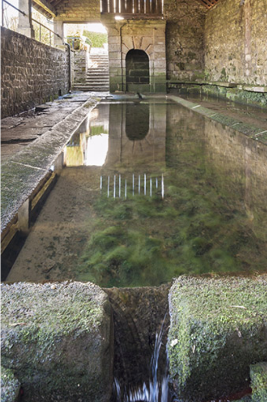
Le bassin et son déversoir.
