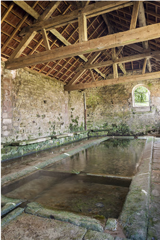
Vue générale des bassins.
