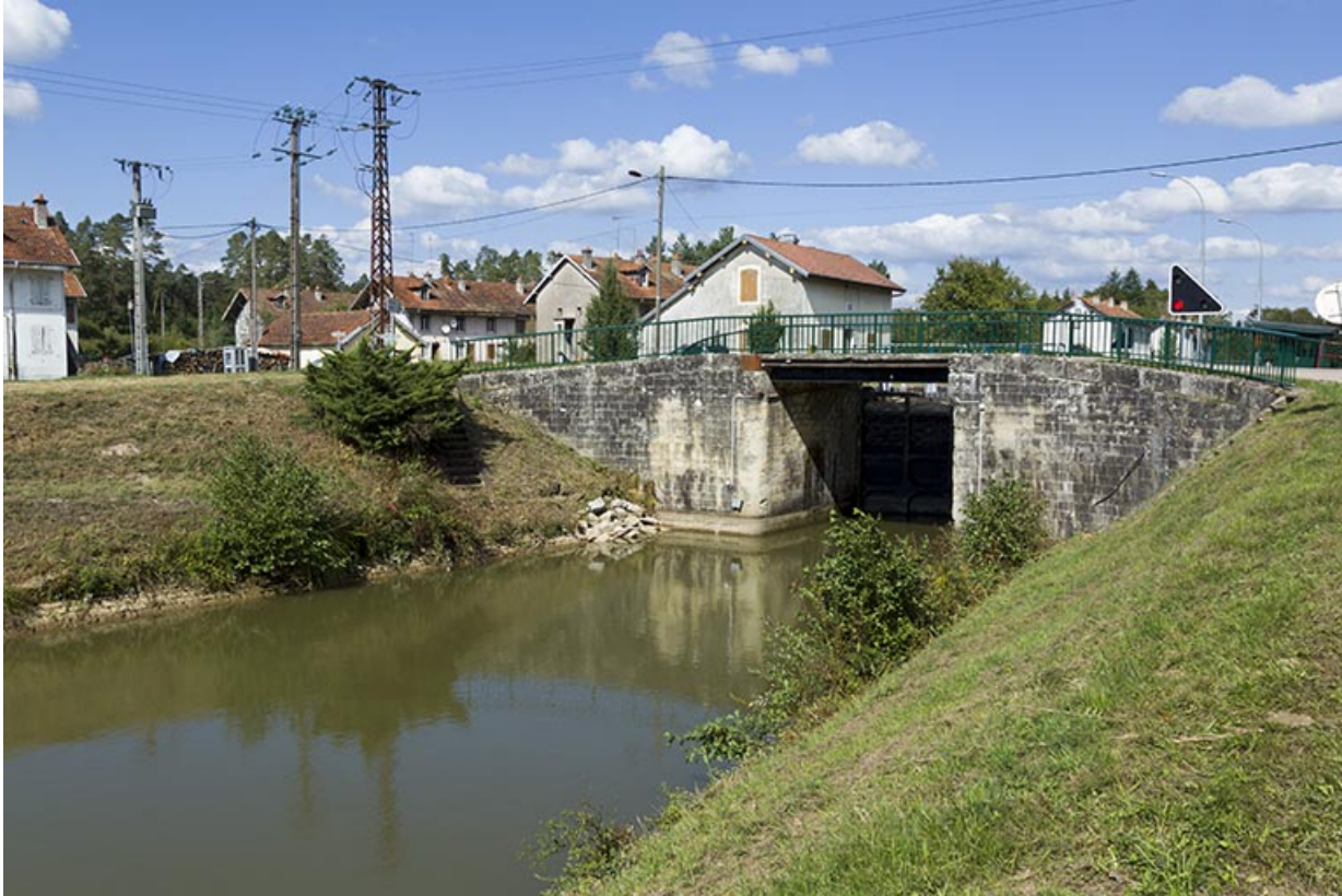
Depuis l'aval, vue sur le pont routier.
