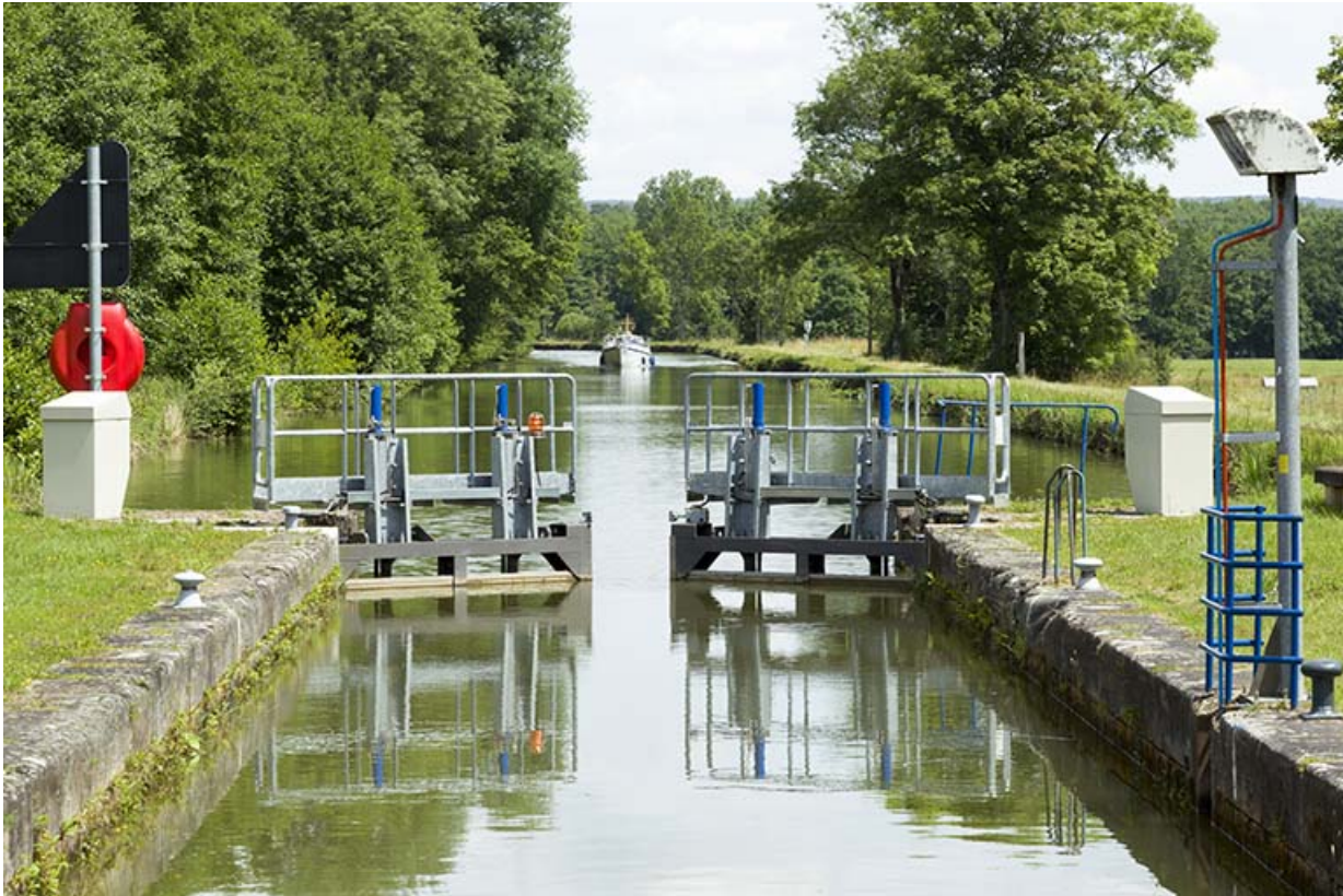
L'ouverture de portes vers l'amont à l'approche d'un bateau avalant. 70, Demangevelle
