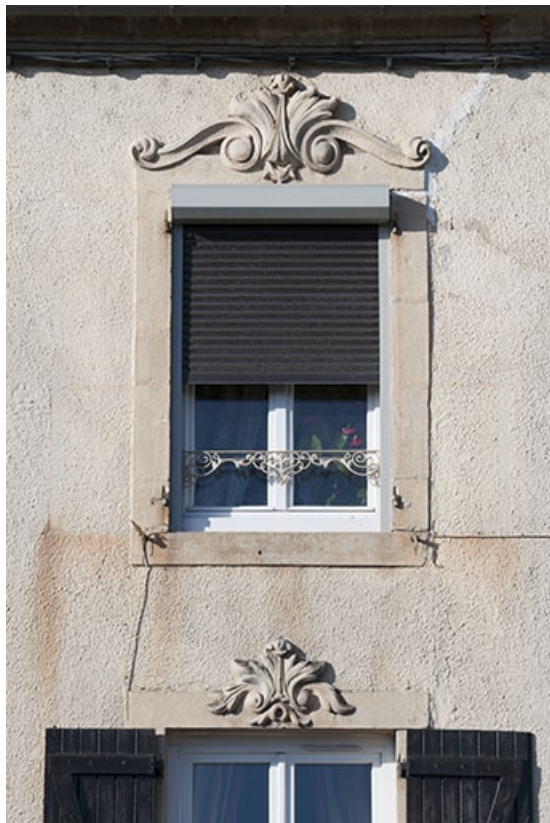
Façade antérieure : détail, décor des baies.
