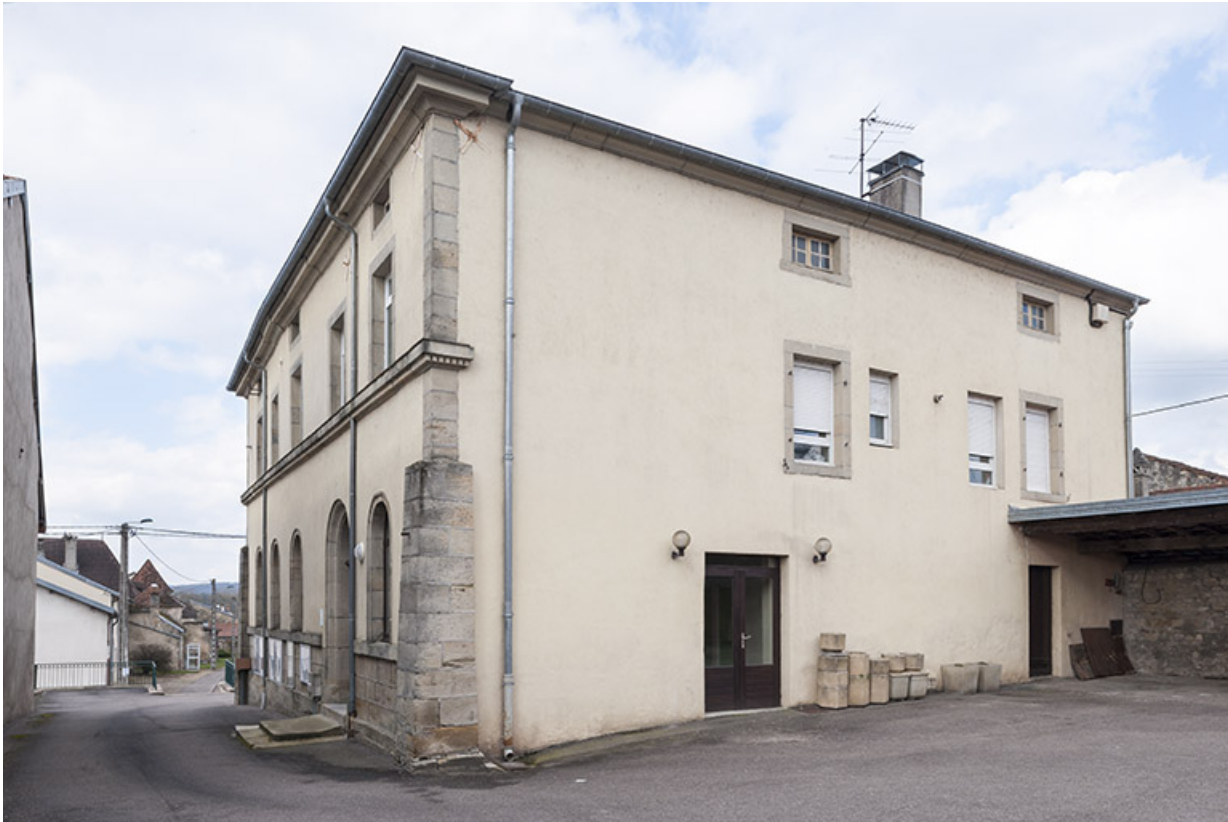
La façade postérieure.
