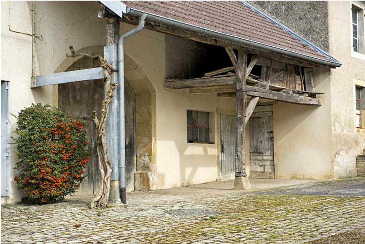
Auvent protégeant l'entrée de la grange.
