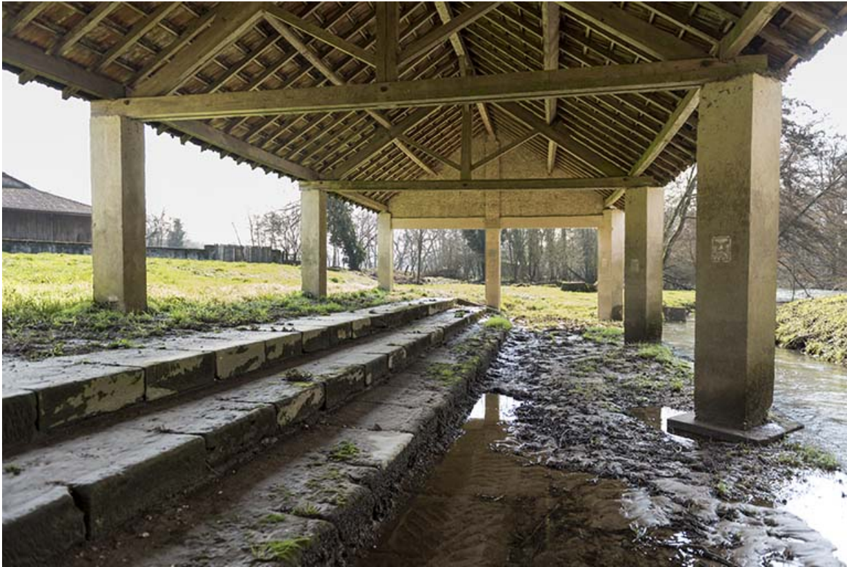
Sous l'ancien lavoir.
