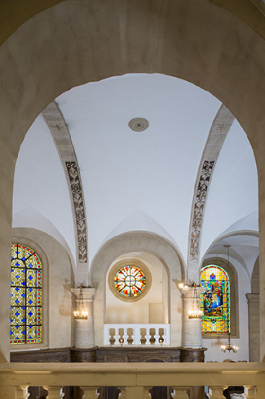
Détail de la voûte.
