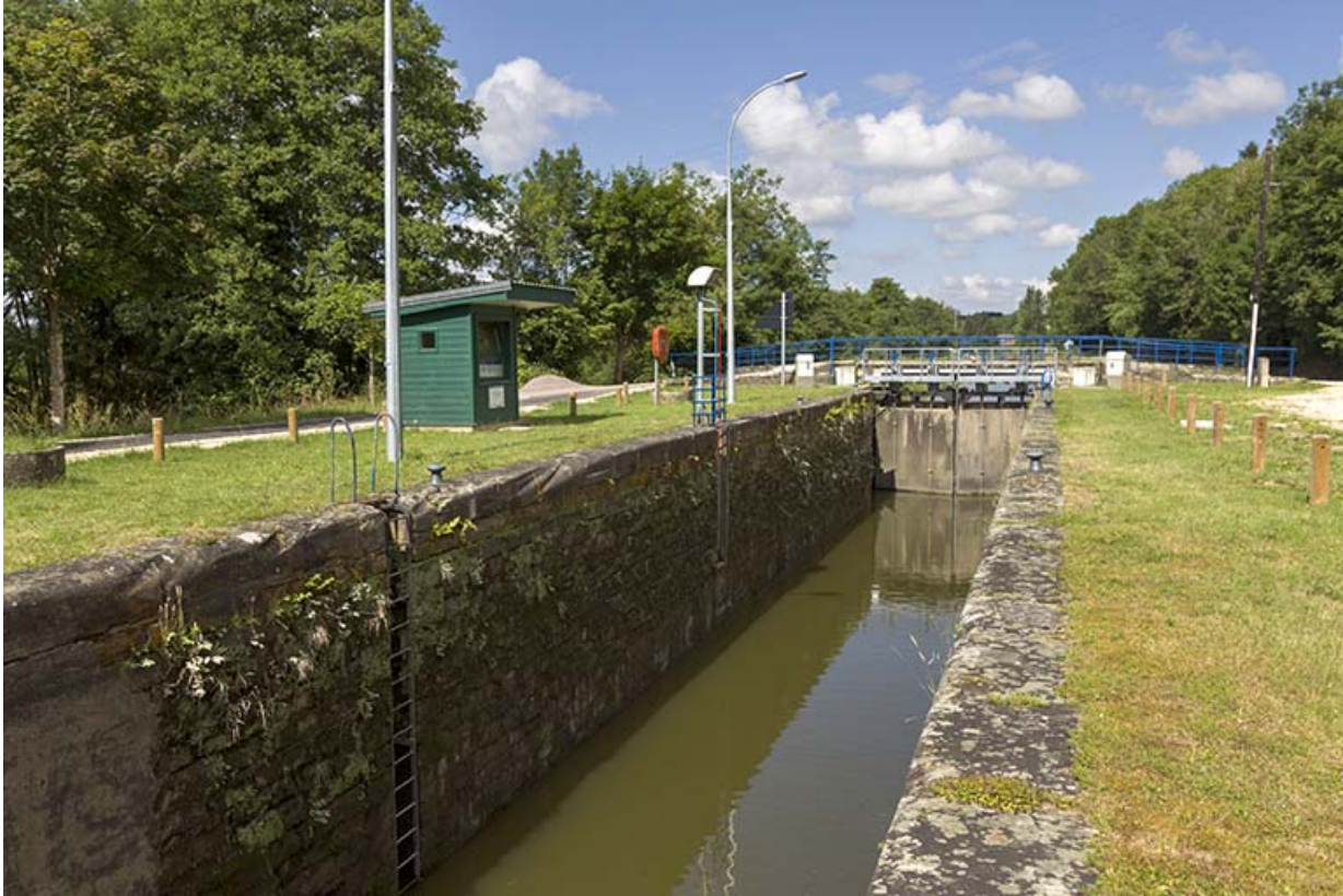
L'écluse et son poste de commande.
