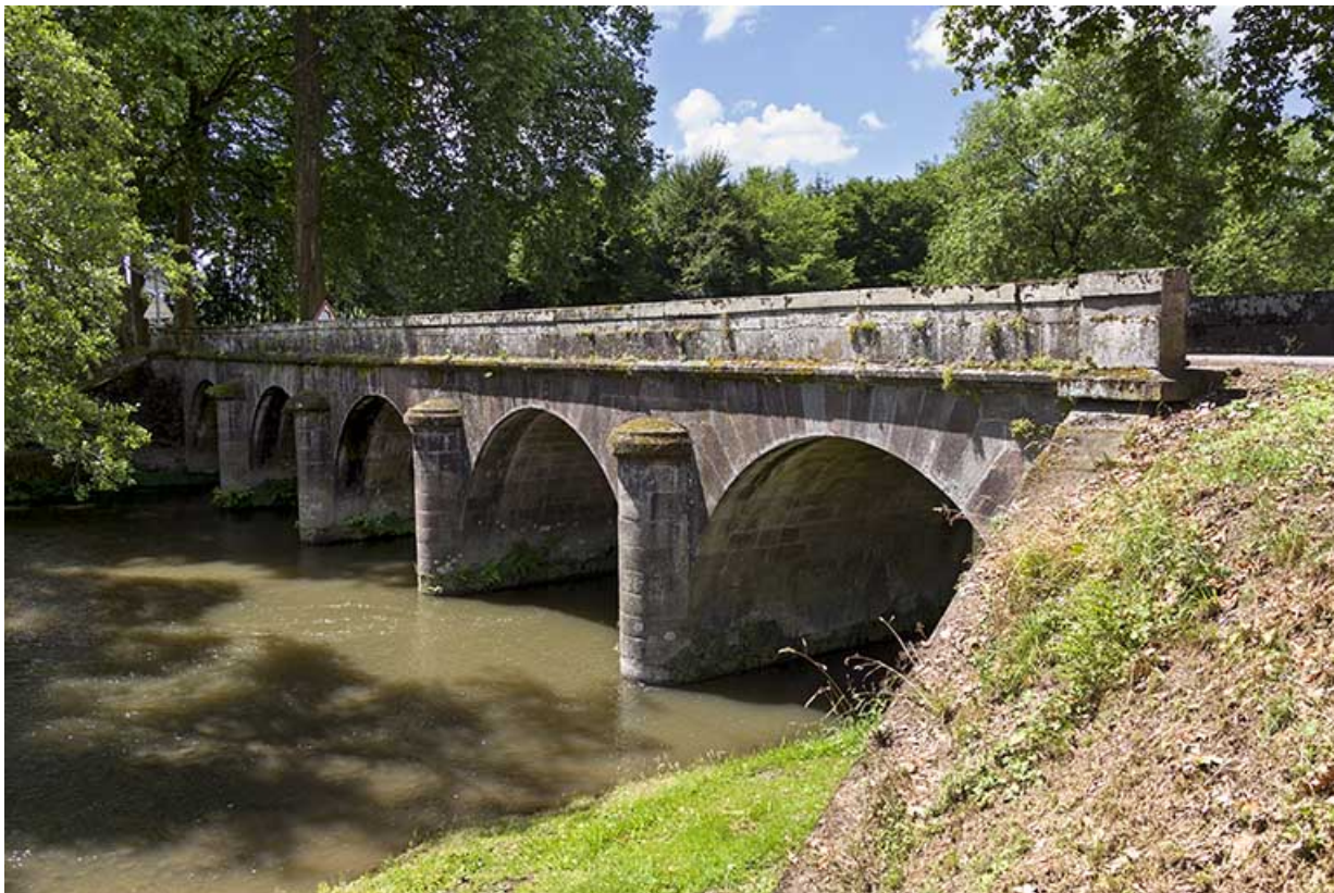
Vue du pont en amont.
