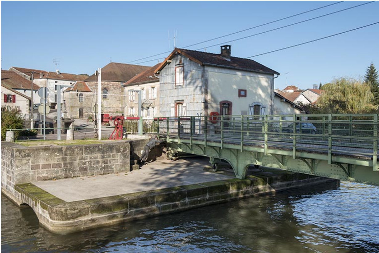
Remise en place du tablier métallique.
