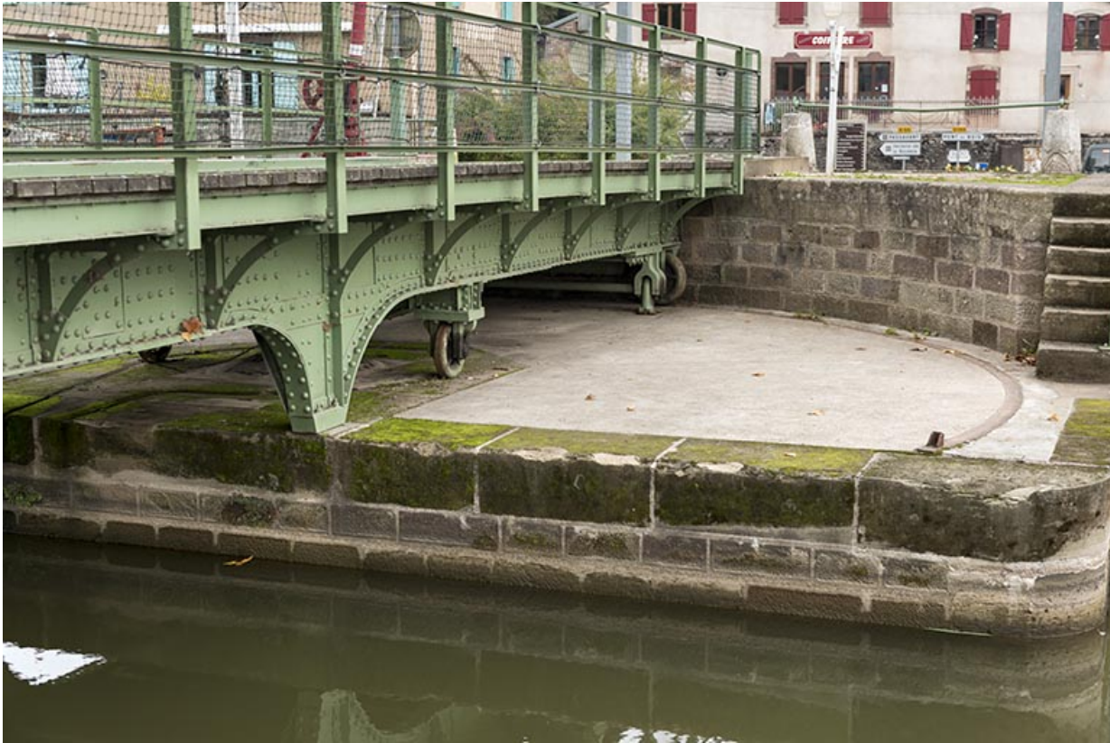
Détail de la plateforme maçonnée.
