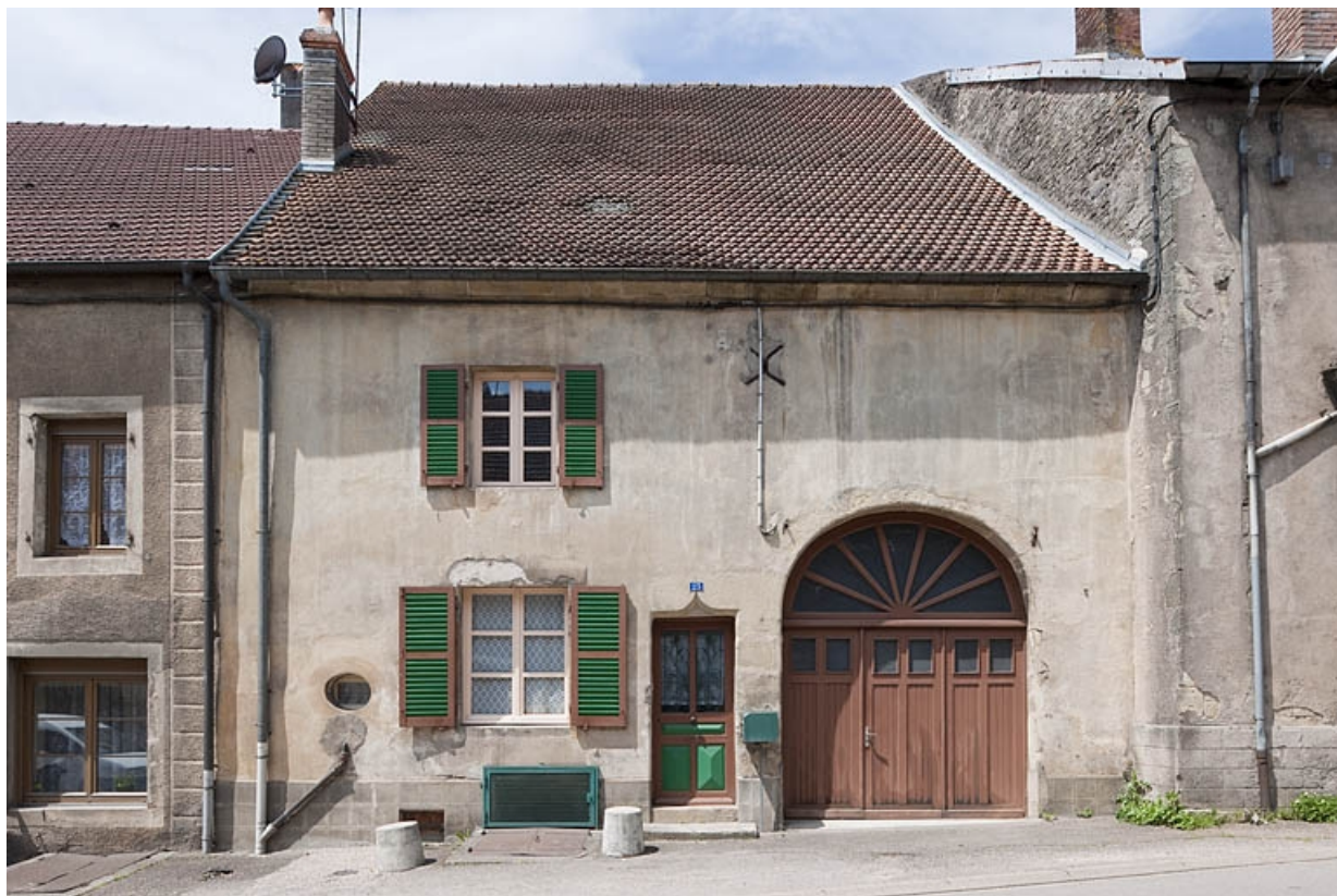
Ferme, 23 Grande Rue : ferme à deux travées.
