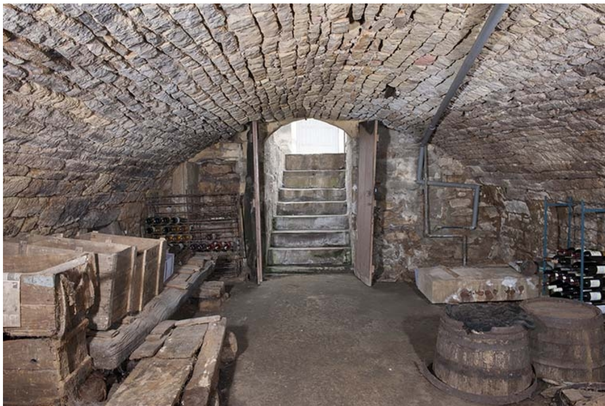
Sous-sol, en direction de l'entrée.
