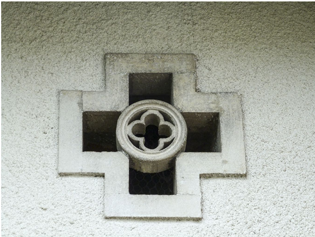
Remise : baie cruciforme de l'étage de comble.
