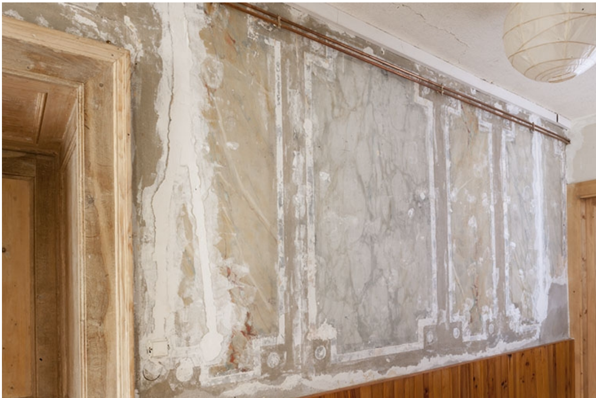
Le vestibule vu depuis l'entrée.
