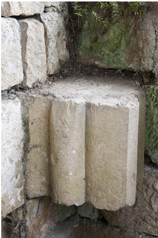
Élément architectural inséré dans le mur d'enclos.
