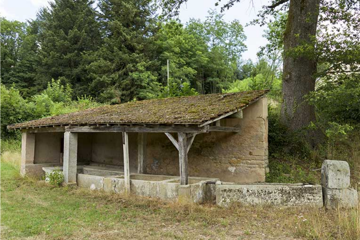
Lavoir, rue des Forges.
