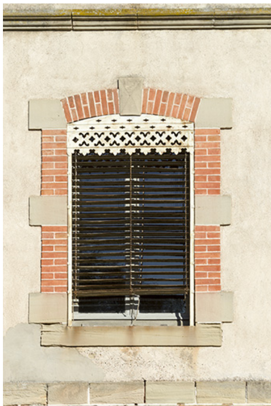
Détail d'une baie.
