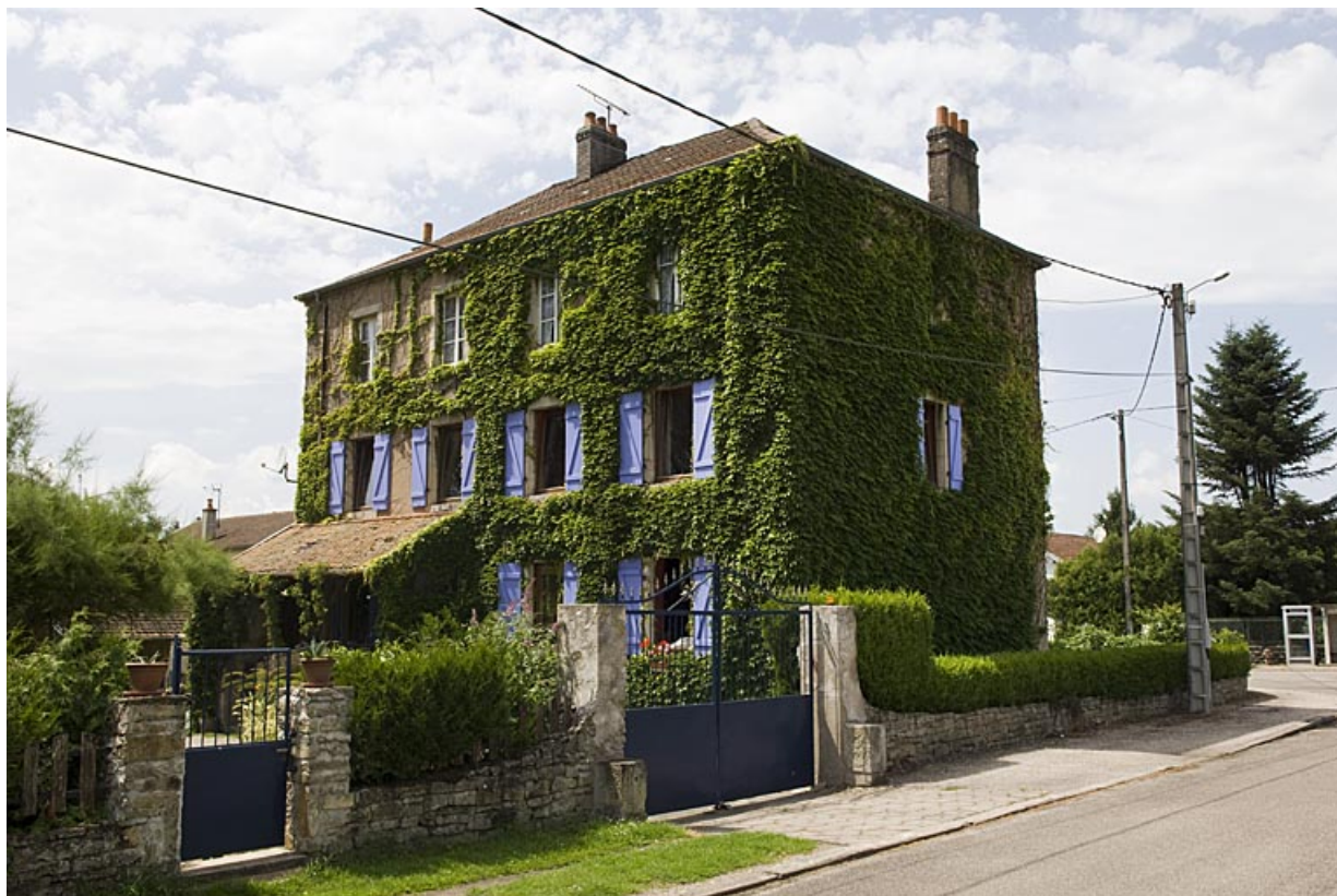
Façade postérieure, vue de trois quarts droit.
