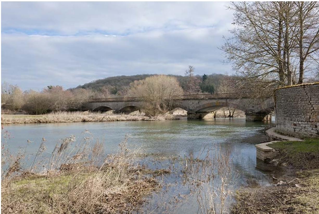
Pont ferroviaire sur la Lanterne (ligne Nancy-Gray).
