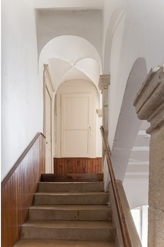
Escalier intérieur conduisant à l'étage.
