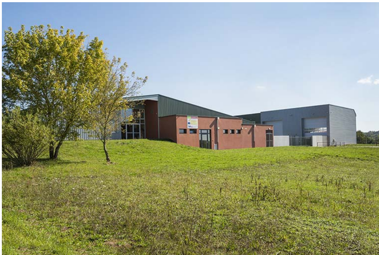
Les deux halles vues du nord-ouest.
