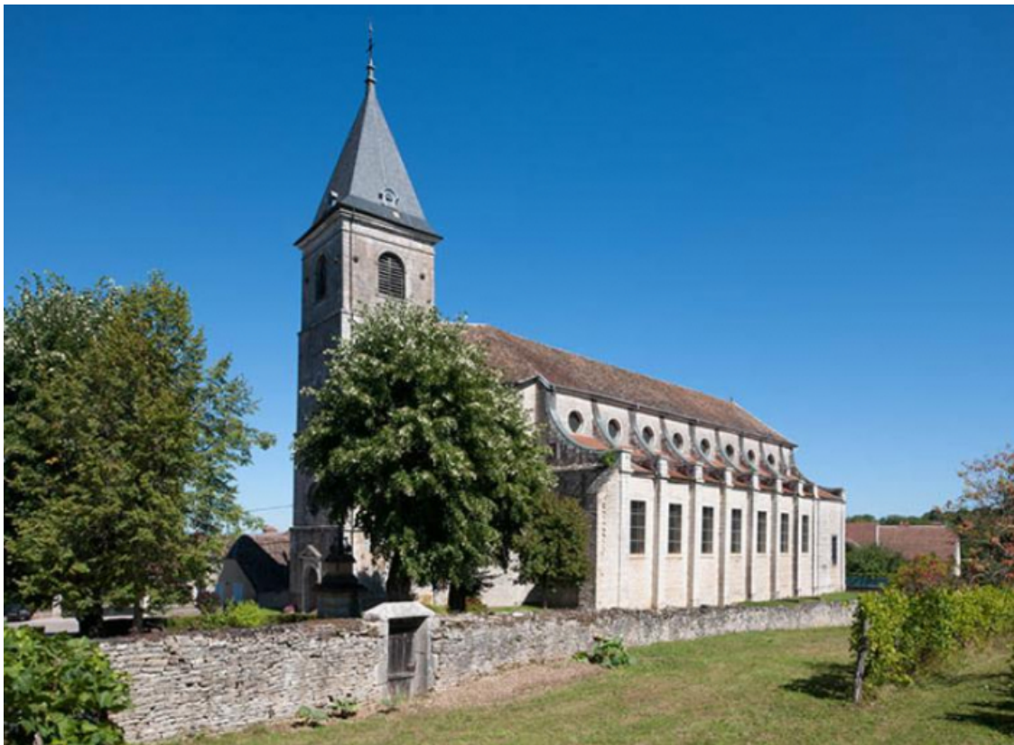
Vue générale sud-ouest de l'église
