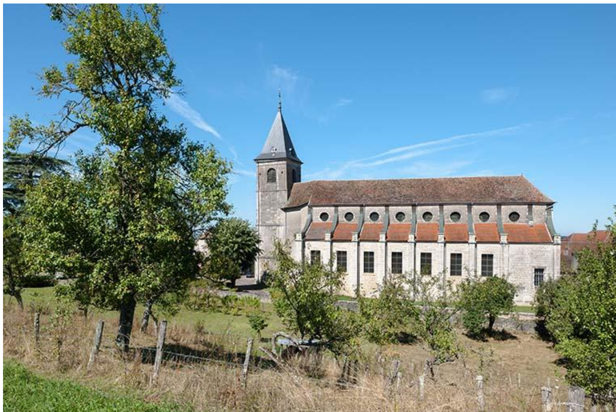
Vue générale sud de l'église
