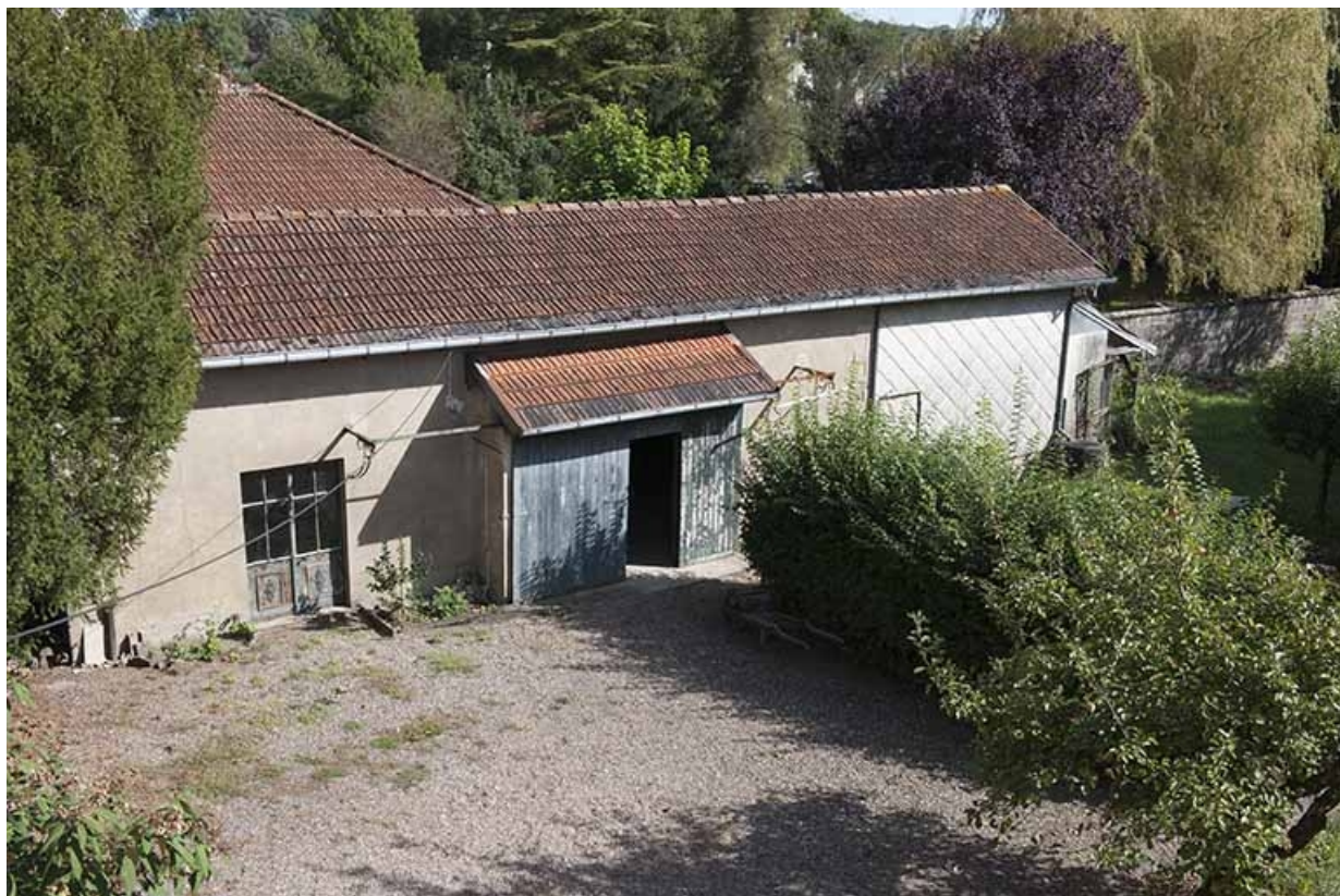
Vue générale de la remise.
