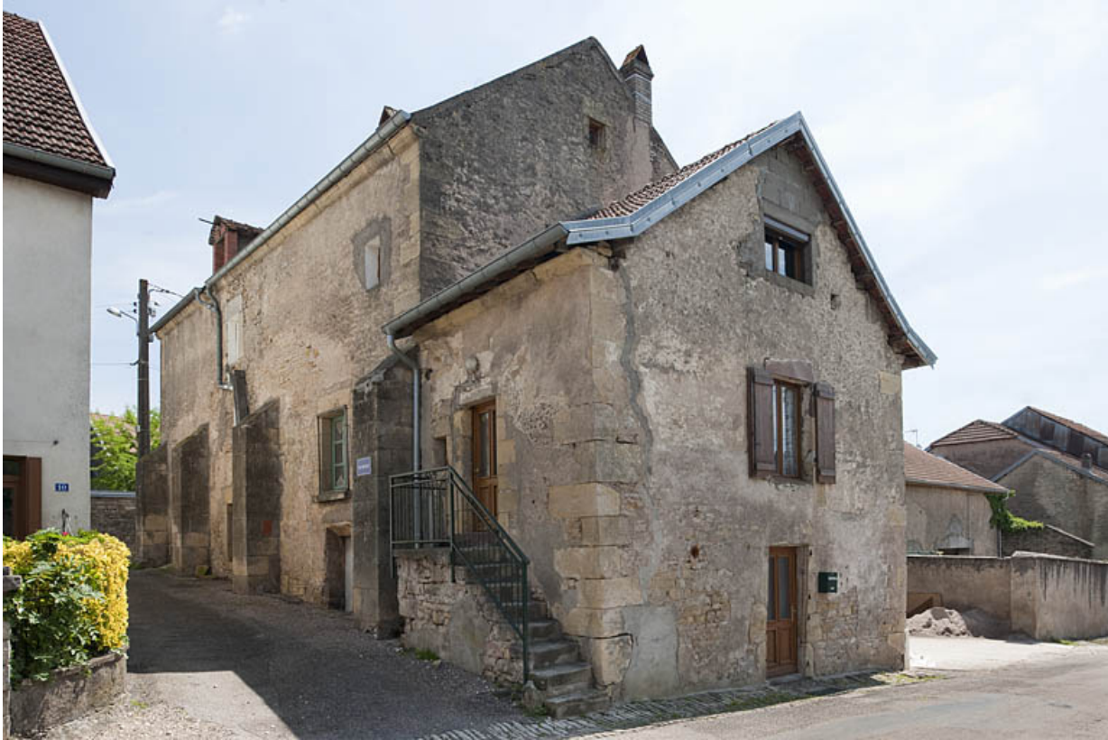
Vue générale depuis la rue Catinat.
