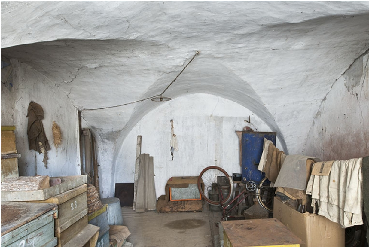
La seconde pièce, en direction de l'escalier.
