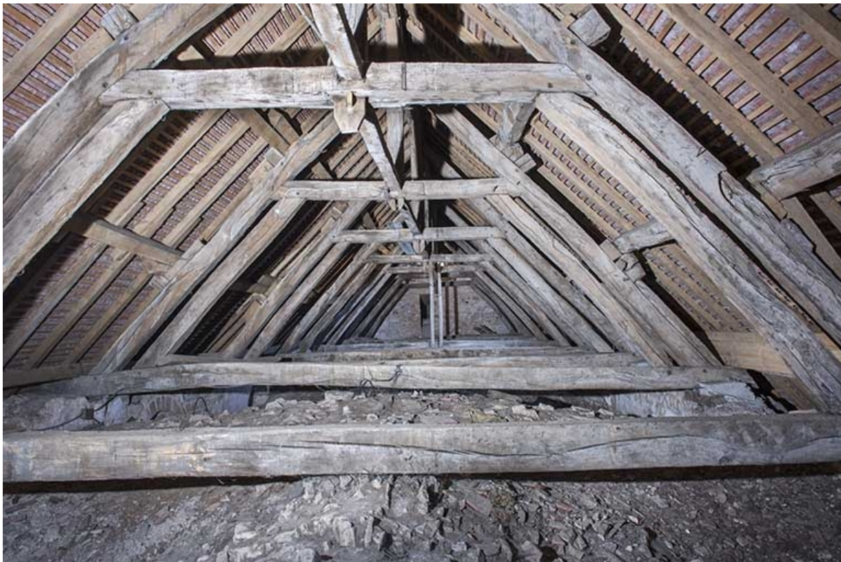
Vue d'ensemble de la charpente.
