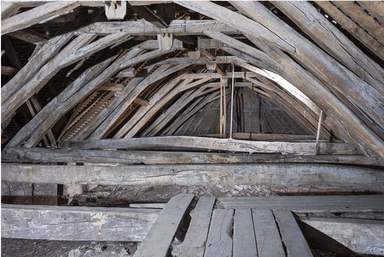
Autre vue de la charpente.
