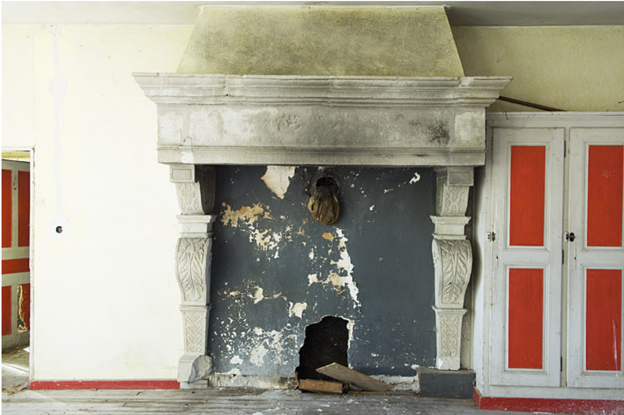
Intérieur : le réfectoire, détail : la cheminée.
