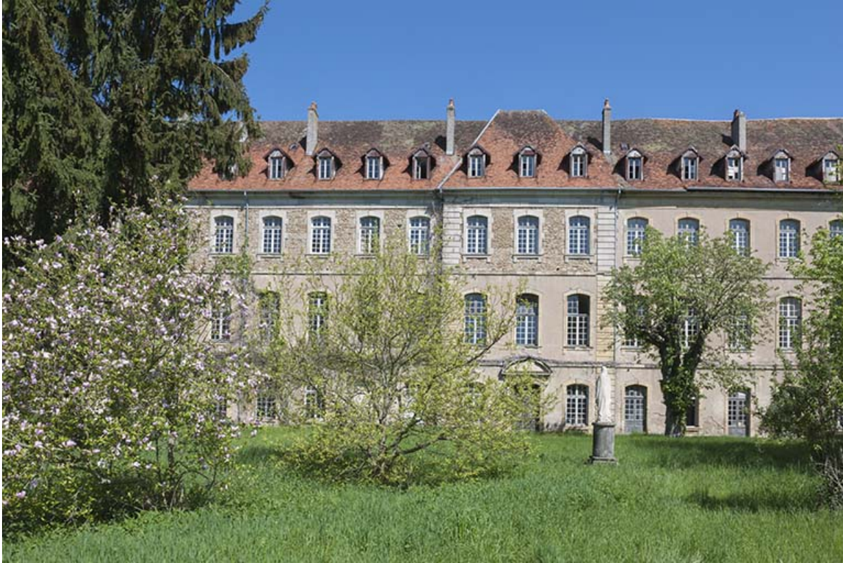
Façade sud vue de face.
