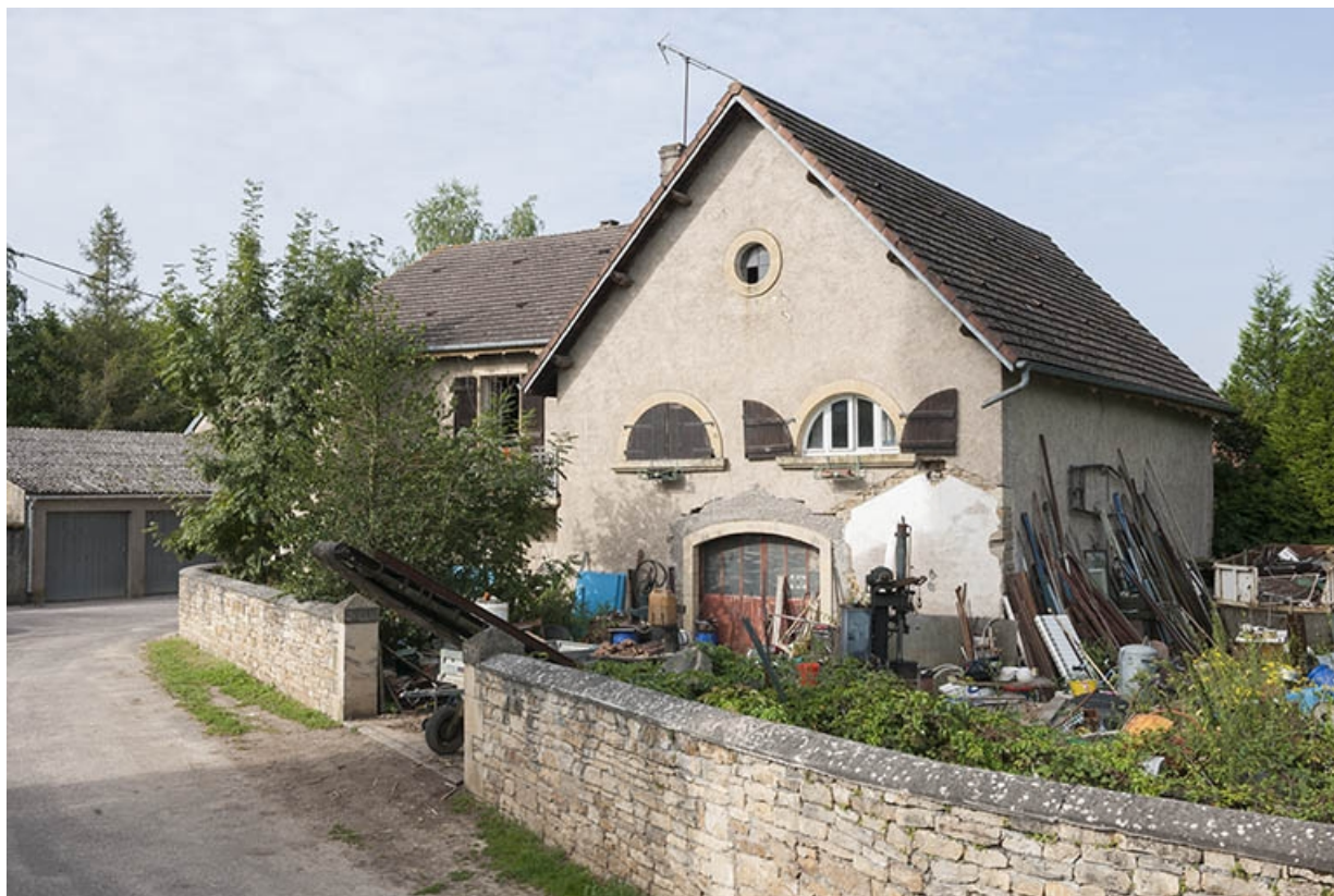
Façades latérale droite et postérieure.
