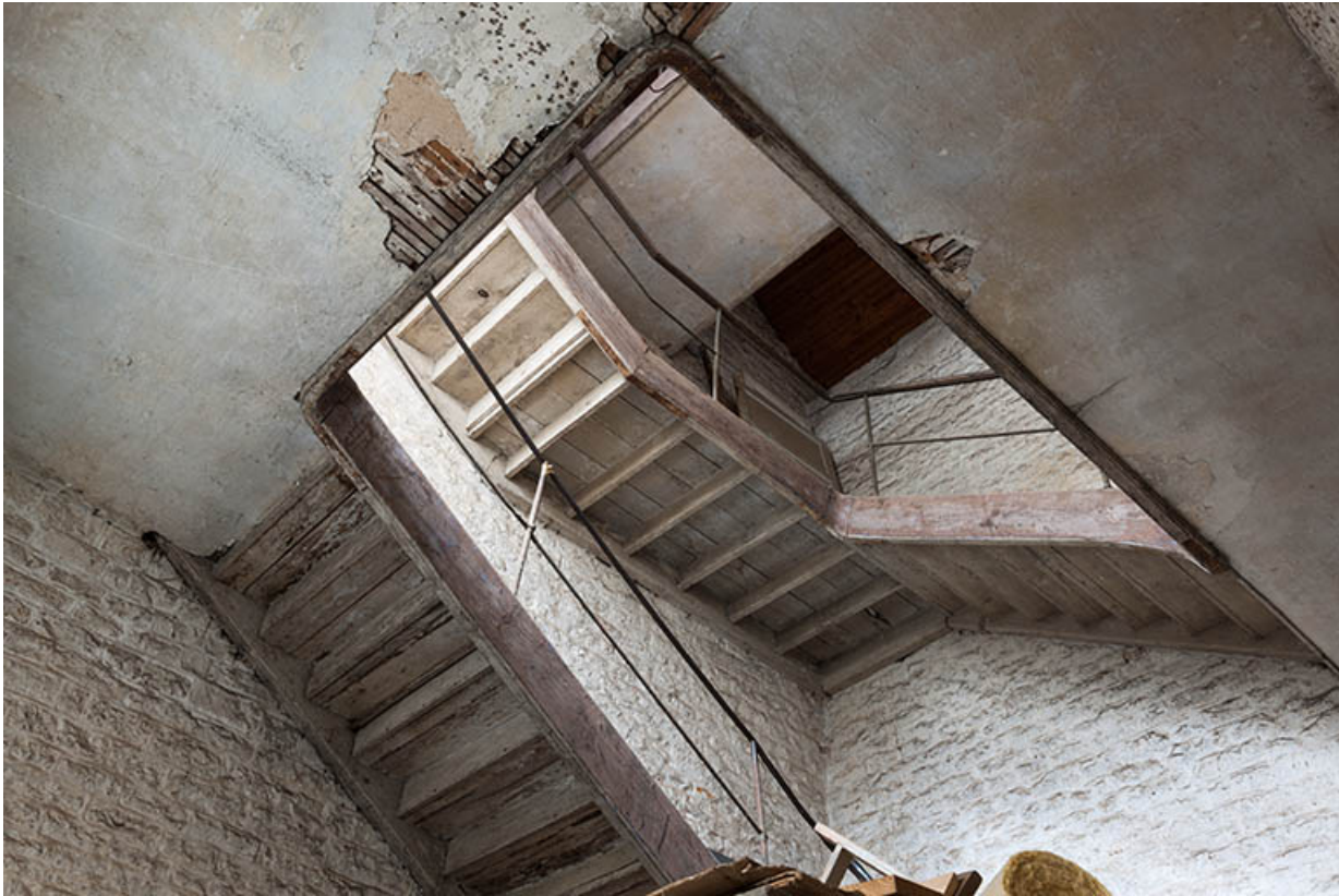
Escalier dans l'atelier des agents.
