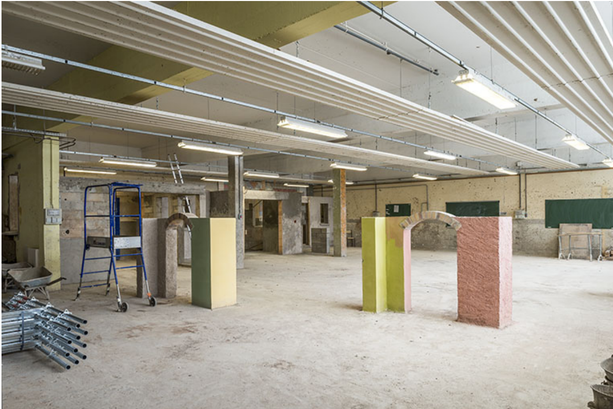
Atelier de gros oeuvre : réalisations en maçonnerie.
