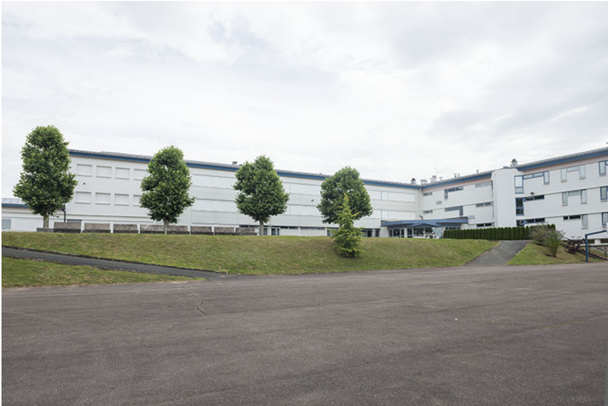
Externat et atelier : façades sur cour.
