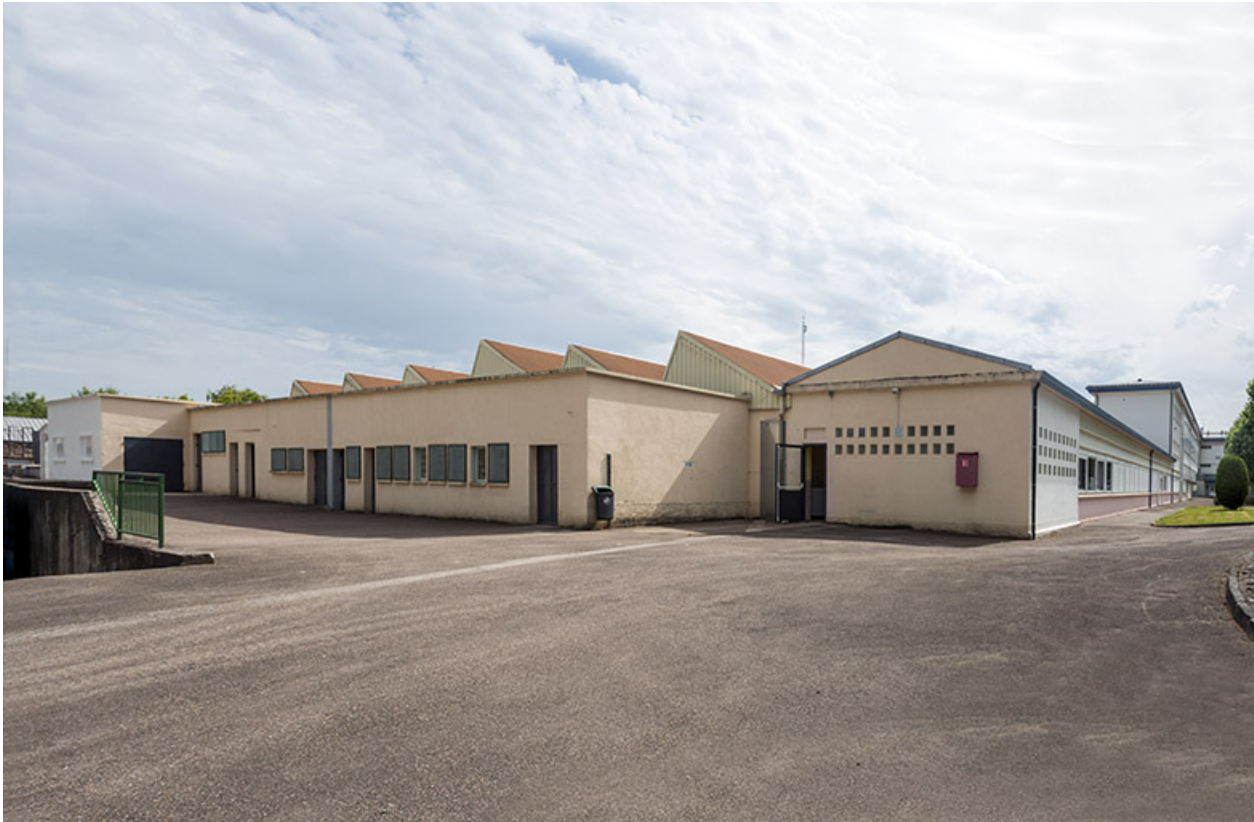
Ateliers : façade latérale.
