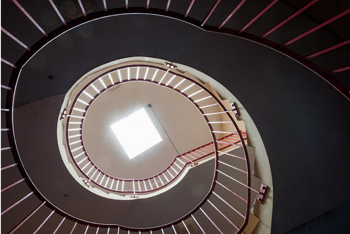
Escalier en vis en béton de l'internat.
