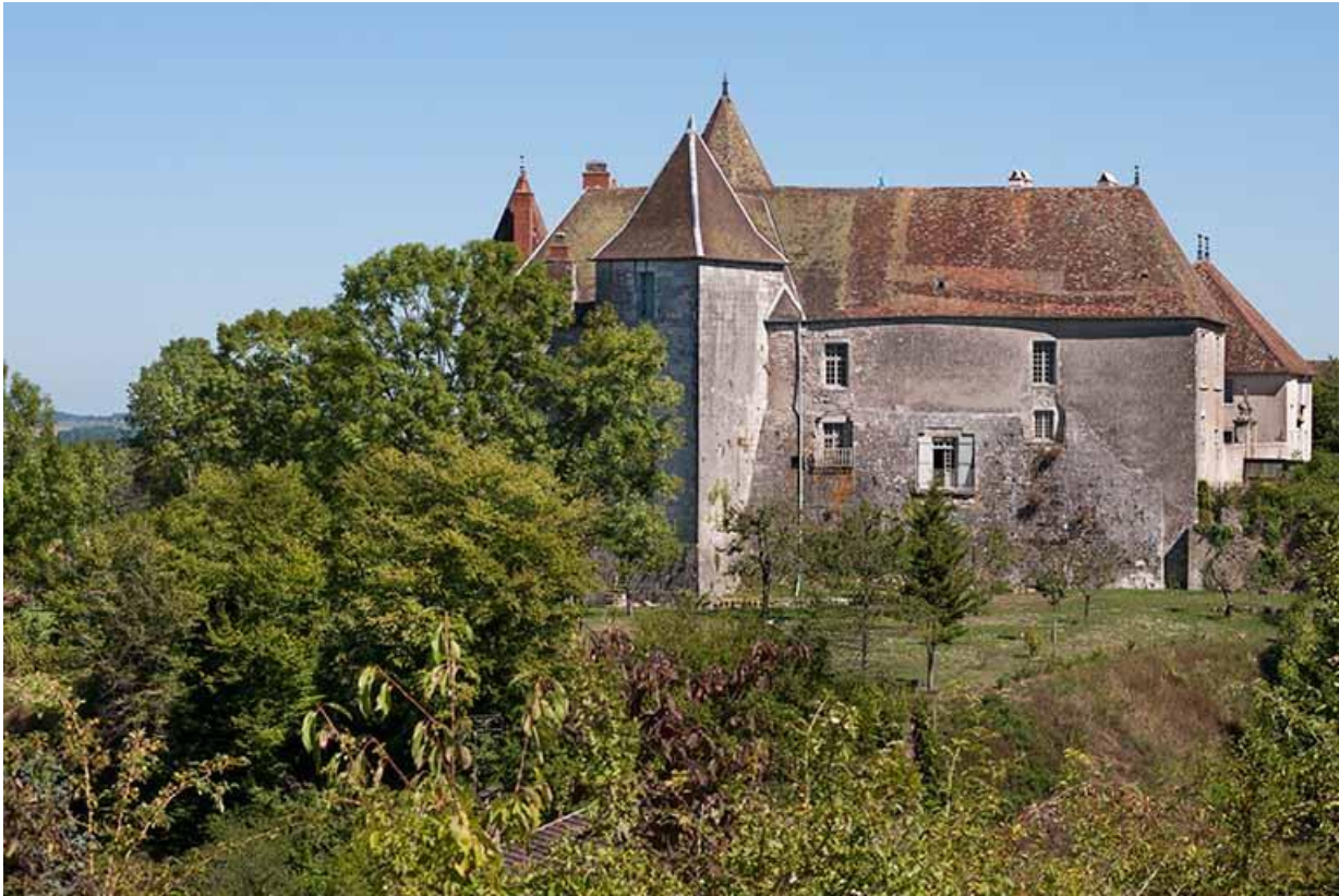
Vue ouest du château
